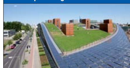
Abb. 6: Headquarters Solon SE – Optimierung im Gebäudebetrieb
